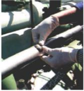
1- Couper toute circulation de fluide dans la canalisation. Nettoyer et gratter la surface à réparer.
