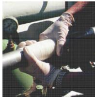
6- Continuer à exercer une pression sur le bandage en mouillant l'extérieur et en le moulant dans le sens de l'enroulement jusqu'à ce qu'il commence à durcir. (sensation de chaleur)
