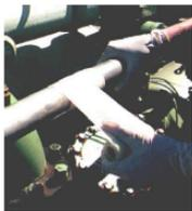
5- Appliquer ADH BRI sur la surface à réparer, en commençant à 50 mm de la fuite, puis enroulez-le en superposant le bandage sur la moitié de sa largeur à chaque tour. Veiller à bien tendre le bandage et à l'utiliser intégralement. Si une bande ne suffit pas, en reprendre une.
